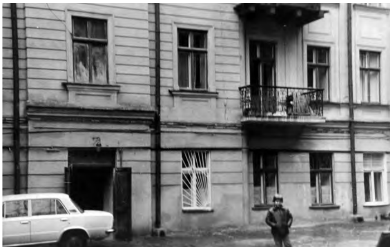
Одесса. Слева от балкона на втором этаже – окно комнаты на ул. Свердлова, 28, где жил Ст.Ст. Чахотин до ареста в 1931 г.
