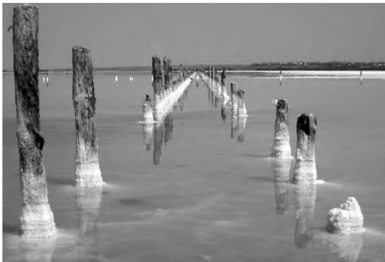
Куяльницкий лиман, август 2013 года. Остатки гидротехнических сооружений Акционерного общества Куяльницко-Хаджибейских соляных промыслов. Фото автора
