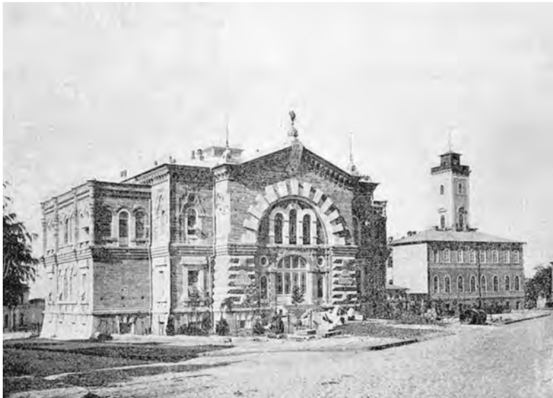
Здание Одесского отделения ИРТО вскоре после возведения. Перед зданием еще видны стройматериалы. Фотография предоставлена Евгением Сокольским
