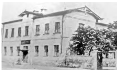
Старопортофранковская, 16. Железнодорожное училище (старое здание до реконструкции, фото 1900-х гг.)
