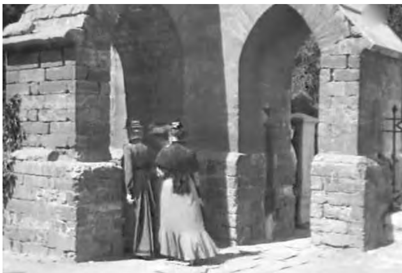
Кадр из фильма «Страницы былого», 1957 год. Здесь видно сложное строение арки. В арке справа видна металлическая колонна, на которую навешивалась калитка, внешне похожая на стойки ограды вдоль усадьбы
