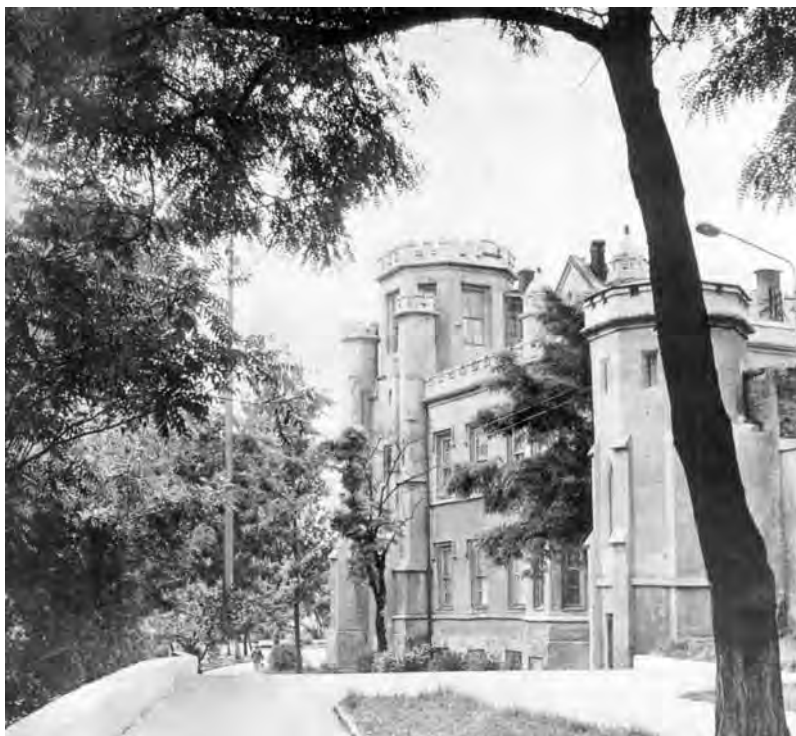
Снимок сделан в 1977 году, и на нем видно отсутствие здесь решетки. А также видна изначальная обработка стен без всякой штукатурки
