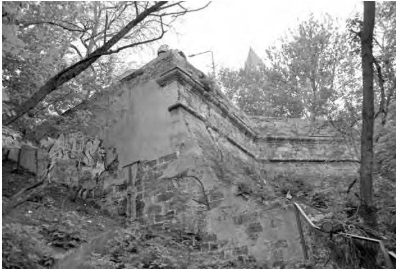
Подпорная стена – терраса перед морским фасадом дворца Бжозовских, современный вид
