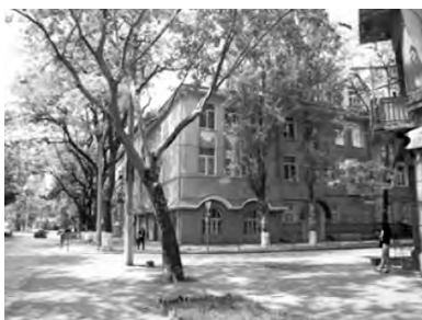
Здание училища – ныне школа № 107. Ул. Толстого, 30
