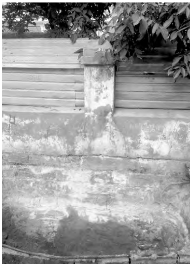
Большая часть каменного забора перед бывшим особняком Софии Потоцкой давно находится под землей в результате значительных отсыпок грунта по ходу нивелирования Софиевской улицы и устройства Нарышкинского спуска. Снимок Виталия Абрамова, 2019 г.
